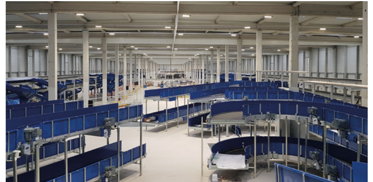
PROLOGIS | Douvrin (62) | 28 000 m 2 Construction d'une messagerie
