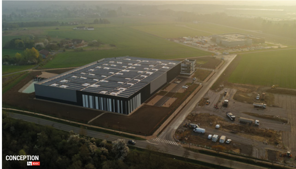
COMET | Orléans (45) | 10 000 m 2 Conception et construction d'une plateforme logistique
