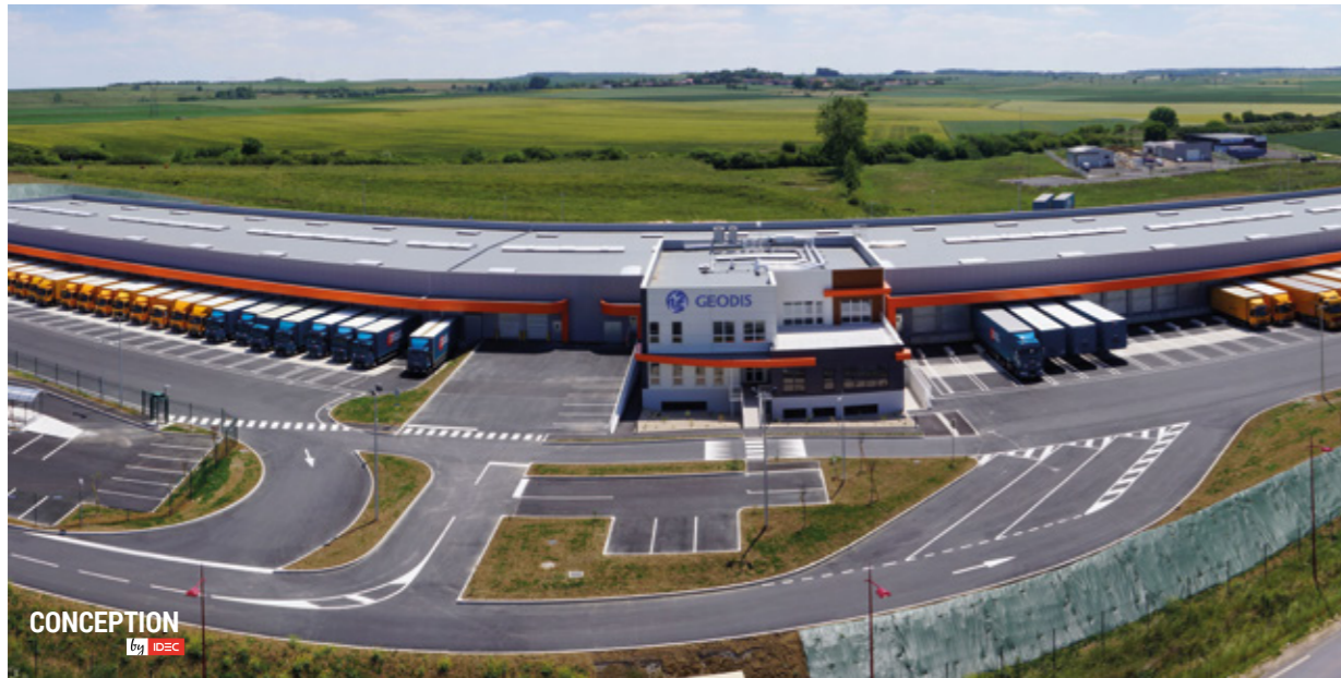
GEODIS | Ville-en-Vermois (54) | 13 000 m 2 Conception et construction d'une messagerie
