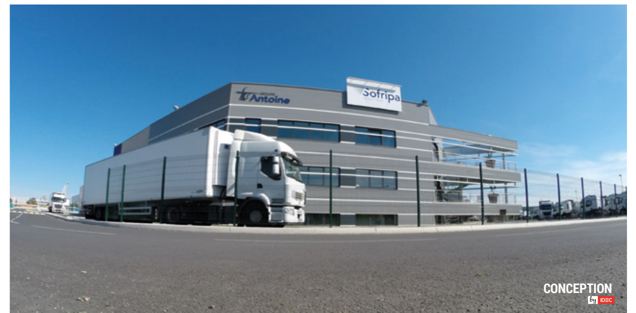
GROUPE ANTOINE | Wissous (91) | 7 400 m 2 Conception et construction d'une messagerie
