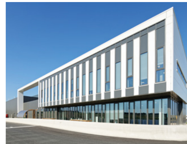
STOCKOMANI | Venette (60) | 72 000 m 2 Construction d'une plateforme logistique
