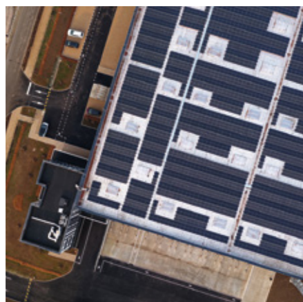
PHOTOVOLTAÏQUE NOUVELLE GÉNÉRATION
