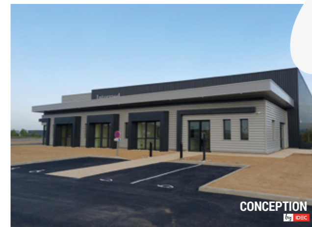
INTERMED | Parçay-Meslay (37) | 1 000 m 2 Conception et construction d'un bâtiment d'activités
