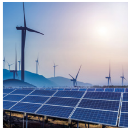
SOLUTIONS ÉNERGÉTIQUES INNOVANTES POUR PARCS & BÂTIMENTS
