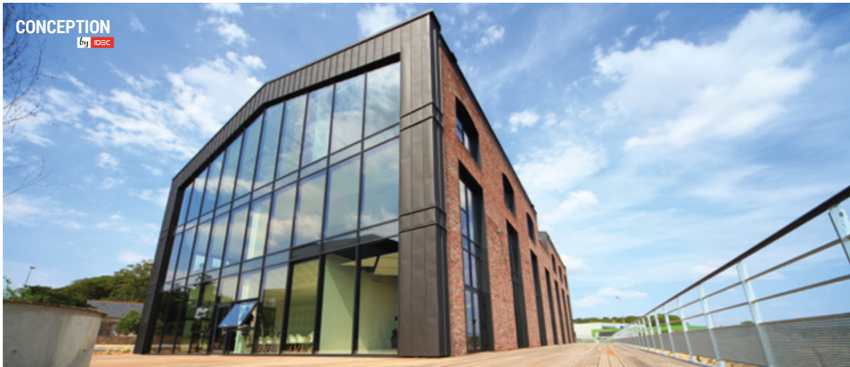
LA FACTORY | Cesson-Sévigné (35) | 4 600 m 2 Conception et construction d'un ensemble de bureaux | Financé par GROUPE IDEC INVEST
